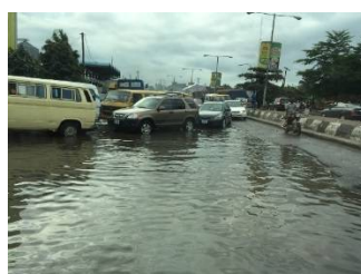
写真 25 冠水した道路
