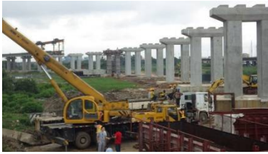
写真 27 建設中の電車
